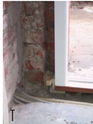
Bandseite der Zarge verschrauben und Türblatt einhängen
